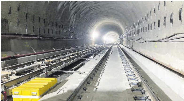
Obras en un túnel para la adaptación de la línea Zaragoza-Madrid a los servicios de autopista ferroviaria.
